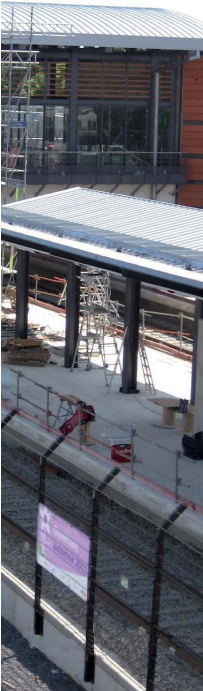
on Créteil-Pointe-du-Lac en cours d'achèvement.
